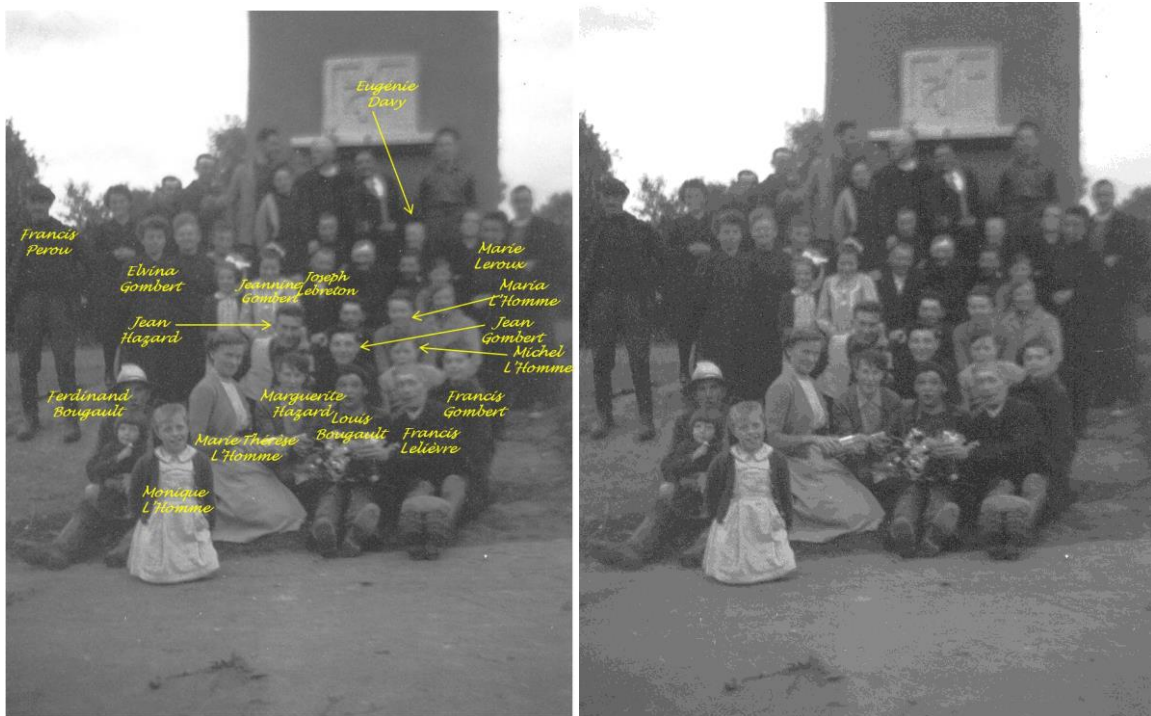
1954 : Inauguration du transformateur de Boudelan. L'auteure de cette photo et des photos de batterie ci-dessus est Francine Bougault (1928-2021), épouse Ruellan.
